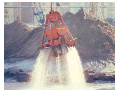
Abb. 3.3-1 Das Grundwasser steht in der Innenstadt oberflächennah an
