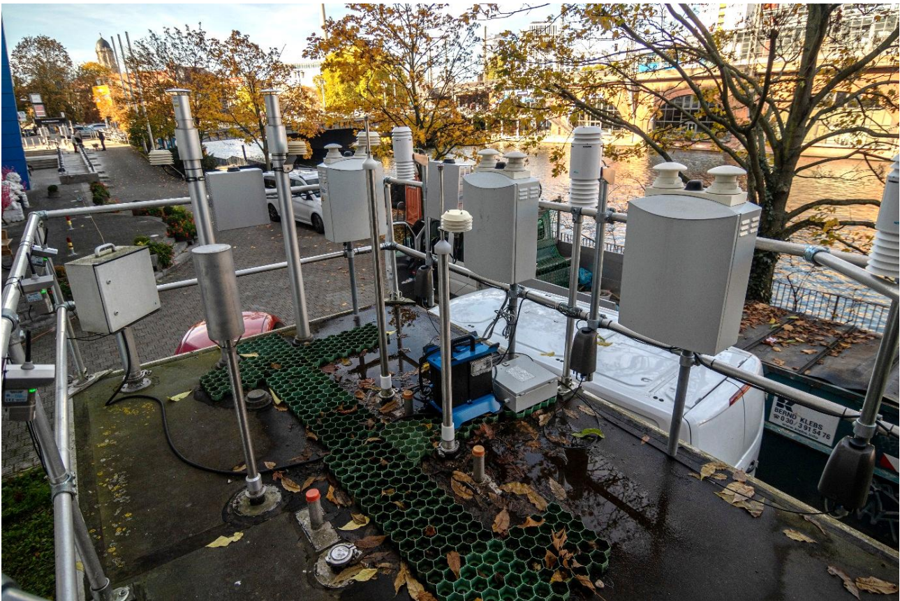
Abbildung 2: Dachansicht des Messcontainers DEBE068 (MC171 Mitte) im Oktober 2022 zur Beendigung der Vergleichsmessungen in der ersten Projektphase.
