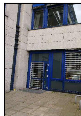
Tür zur Pförtnerloge
