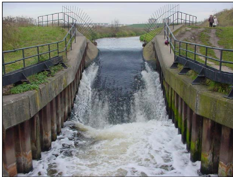
Bild 1: Absturzbauwerk in der Neuen Wuhle, nicht durchgängig, ca. 50 m oberhalb des Zusammenflusses von Wuhle und Neuer Wuhle, Abschnitt 1.
