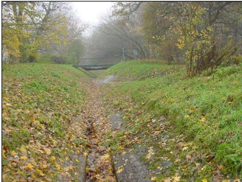
Bild 5: Mit verlegten Feldsteinen ausgekleidetes Bett des Fredersdorfer Mühlenfließes zwischen Rahnsdorfer Stausee und Fürstenwalder Damm, Abschnitt 1 (bzw. Abschnitt 10 für die 0,1 km Kartierung).
