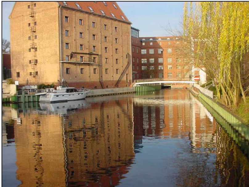
Bild 3: Einmündung des Tegeler Fließ in den Tegeler Hafen im Bereich der ehemaligen Humboldtmühle, Abschnitt 1. Unterhalb des roten Quergebäudes befindet sich ein nicht durchgängiger Absturz.
