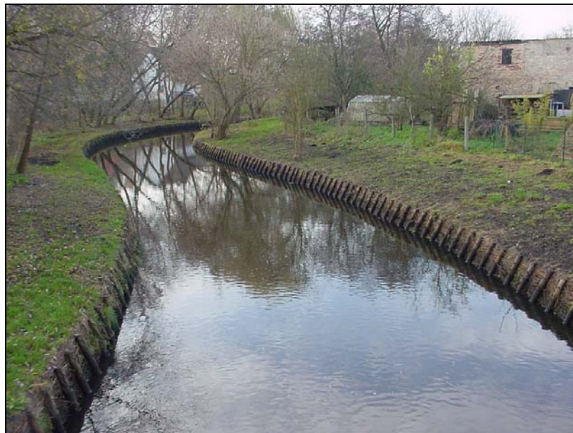
Bild 4: Starker Uferverbau und Begradigungen des Neuenhagener Mühlenfließes unmittelbar südlich der S-Bahn-Brücke beim S-Bahnhof Hirschgarten, Abschnitt 2.
