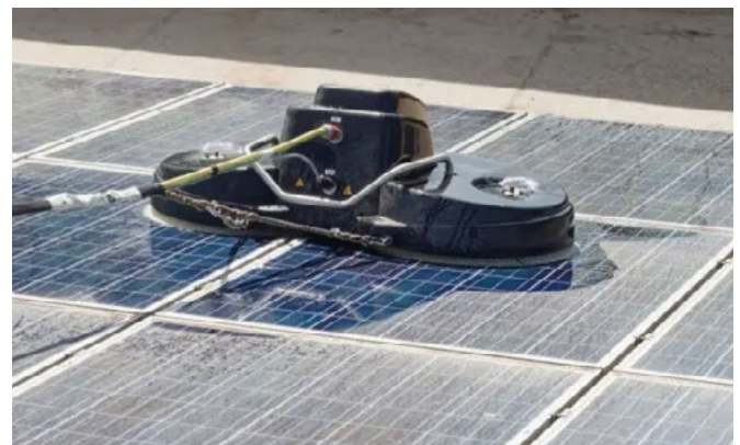
Abb. 18 | Professionelle Reinigung mithilfe einer Reinigungsmaschine /19/
