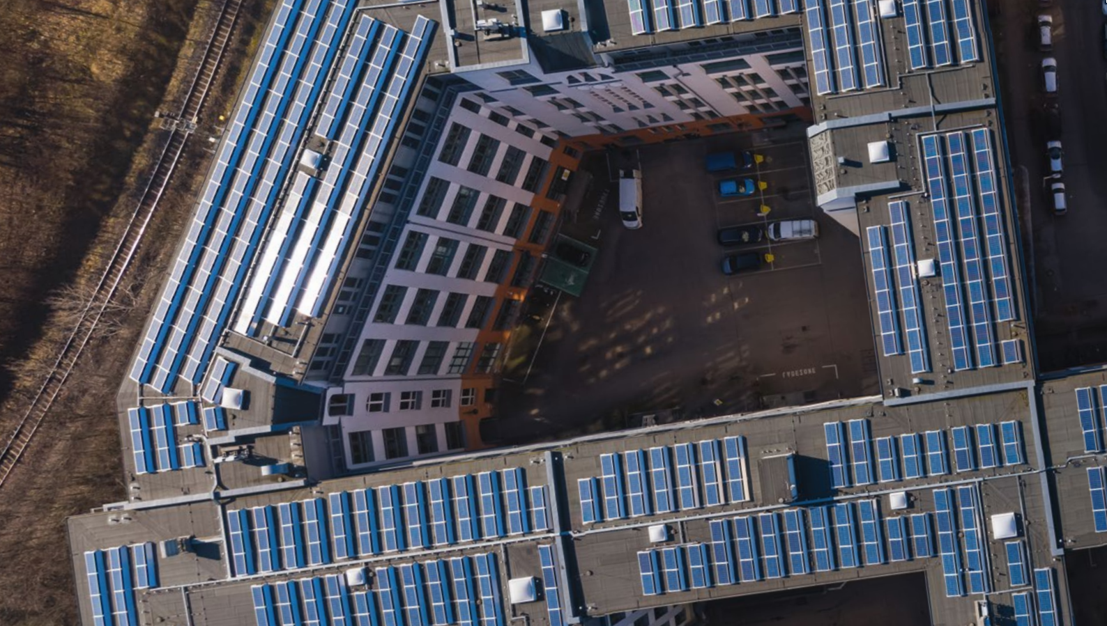
Abb. 5 | Die PV-Anlagen auf dem Dach des Hauptsitzes der GSG in Berlin-Schöneberg liefert Mieterstrom /3/ (mehr zu Mieterstrom siehe Kapitel 5.4 - S. 22 )
