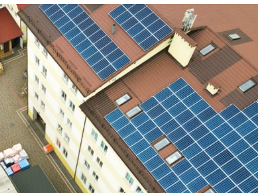
Abb. 11 | v. l. n. r.: Module auf Schrägdach mit Südausrichtung /7/, Flachdach mit OST-West-Ausrichtung /8/, Fassade mit integrierten Modulen /9/
