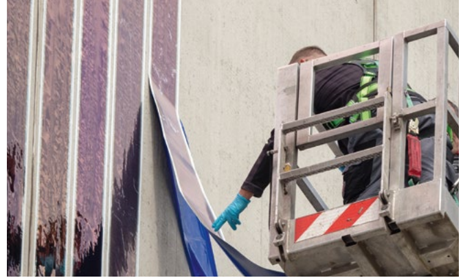
Abb. 7 | Solarfassade mit Dünnschichtmodulen an einem Bürogebäude der HTW Berlin /5/, Solarfolie - Montagearbeiten bei der Schneller Mühle in Donauwörth /6/, für Statikprobleme auf Dächern oder an Fassaden sind Leichtbaumodule oder Solarfolien geeignet
