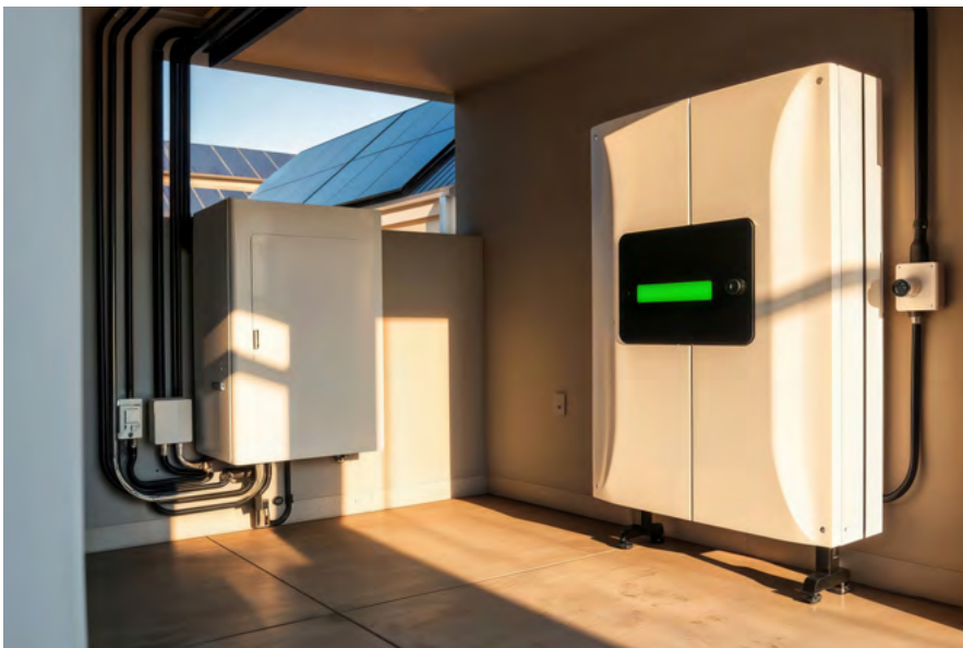
Abb. 36 | Stromspeicher in Verbindung mit einer PV-Anlage.
