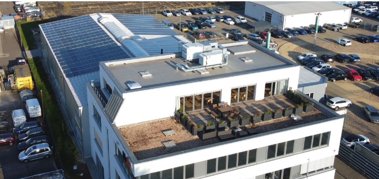
Abb. 28 | Unternehmensgebäude der KleRo GmbH Roboterautomation – Dachansicht mit Süd-Nord ausgerichteten PV-Modulen /22/
