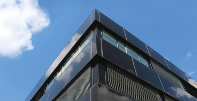
Abb. 7 | Solarfassade mit Dünnschichtmodulen an einem Bürogebäude der HTW Berlin /5/, Solarfolie - Montagearbeiten bei der Schneller Mühle in Donauwörth /6/, für Statikprobleme auf Dächern oder an Fassaden sind Leichtbaumodule oder Solarfolien geeignet
