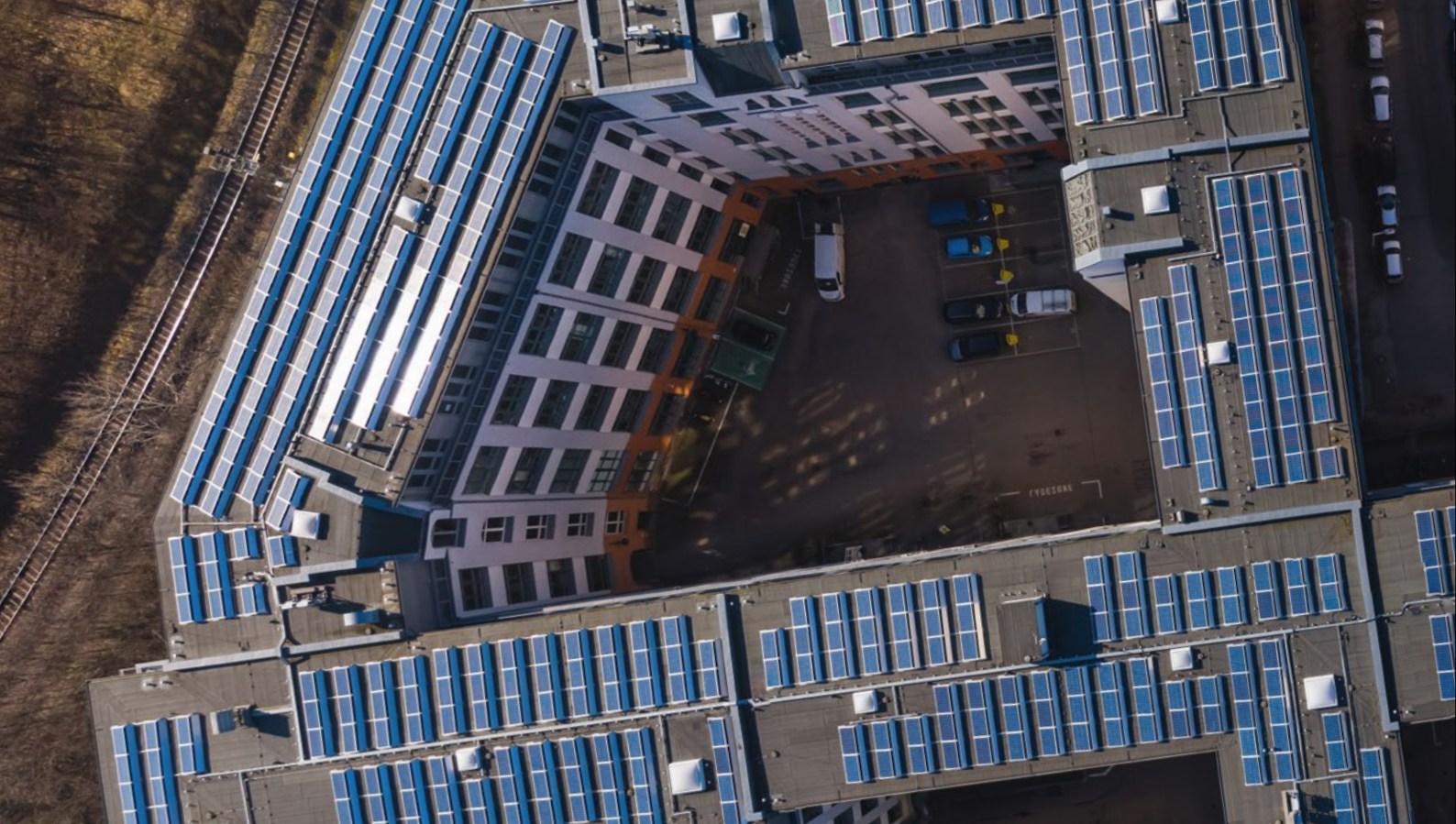
Abb. 5 | Die PV-Anlagen auf dem Dach des Hauptsitzes der GSG in Berlin-Schöneberg liefert Mieterstrom /3/ (mehr zu Mieterstrom siehe Kapitel 5.4 - S. 22 )
