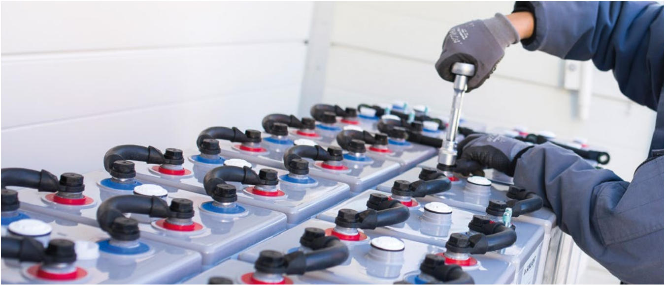
Abb. 14 | Blei-Gel-Speicher in Reihe geschaltet /17/
