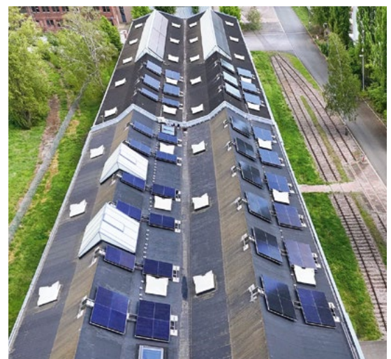
Abb. 32 | erweiterte PV-Anlage auf dem Dach 2024 /25/
