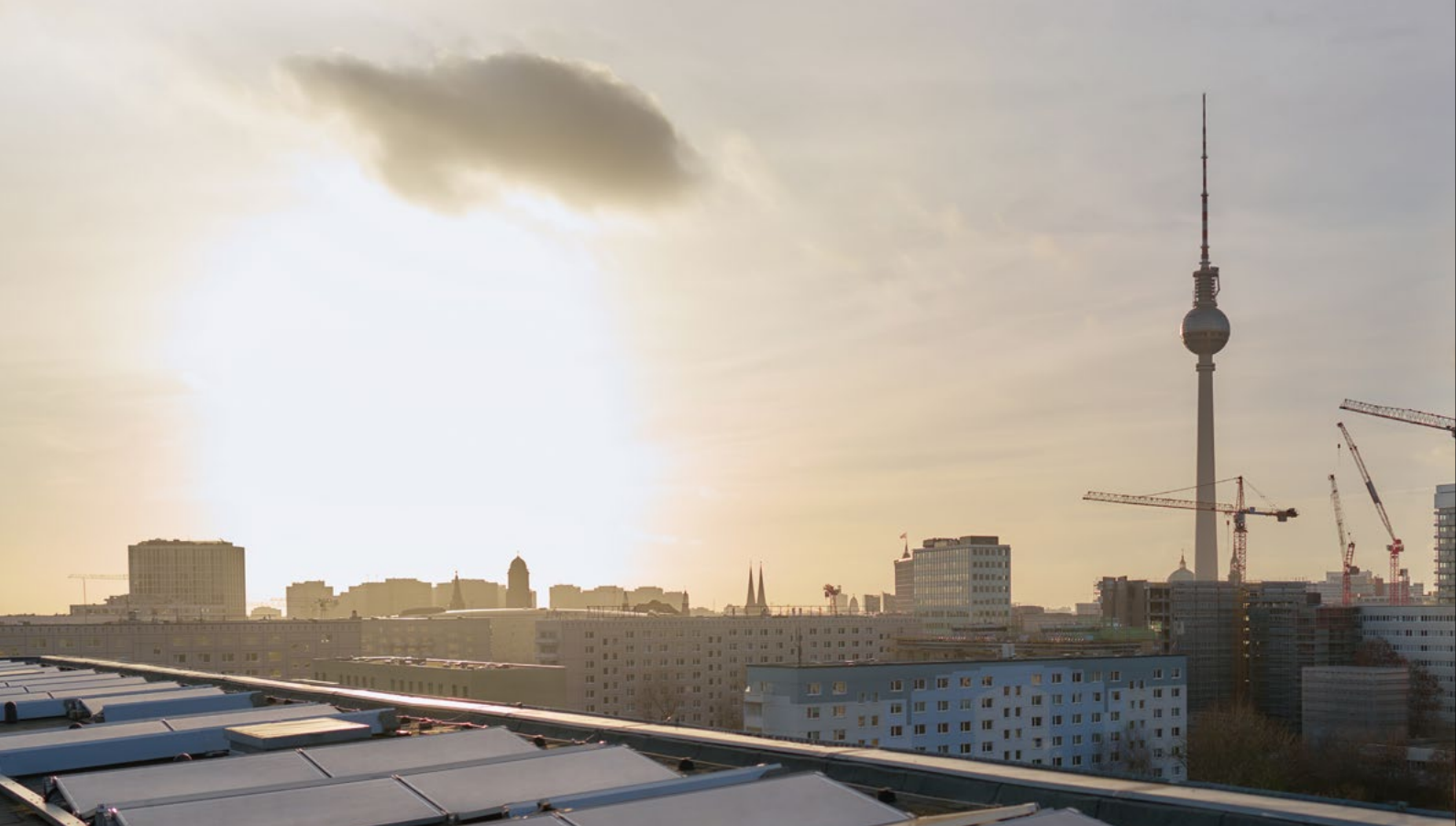
Abb. 25 | Berlin bietet ein großes Potential an ungenutzten Dachflächen für den Betrieb von PV-Anlagen /20/
