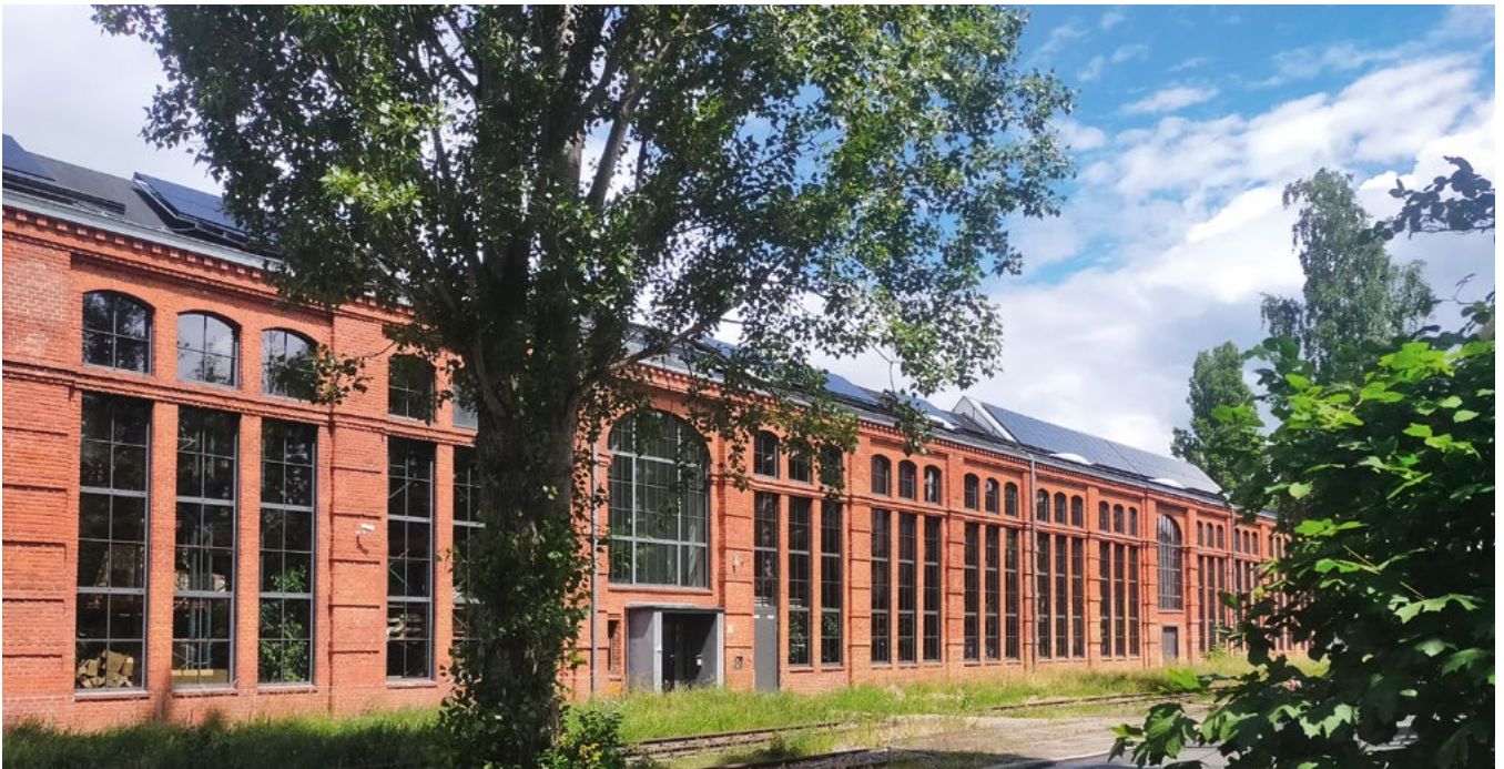
Abb. 30 | PV-Anlage auf der denkmalgeschützte Kanonenhalle in Berlin
