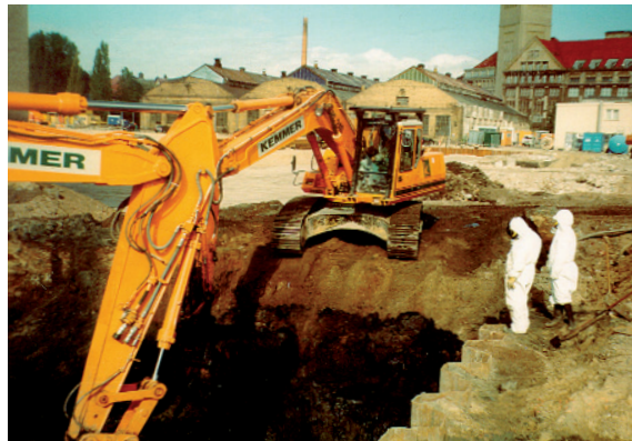
Abb. 5.2-1 Bodensanierung auf dem Gelände des ehemaligen Kabelwerks Oberspree
