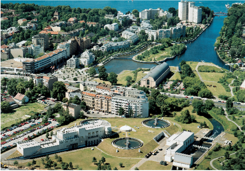
Abb. 3.1-13 Oberflächenwasseraufbereitungsanlage in Tegel im Vordergrund links, dahinter der Tegeler Hafen
