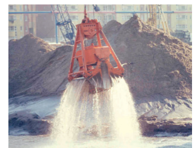
Abb. 3.3-1 Das Grundwasser steht in der Innenstadt oberflächennah an
