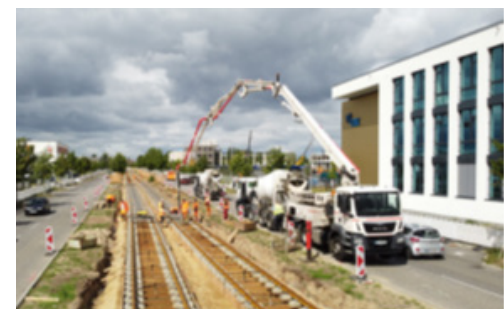
Baufortschritt im August 2020 © Berliner Verkehrsbetriebe (BVG)
