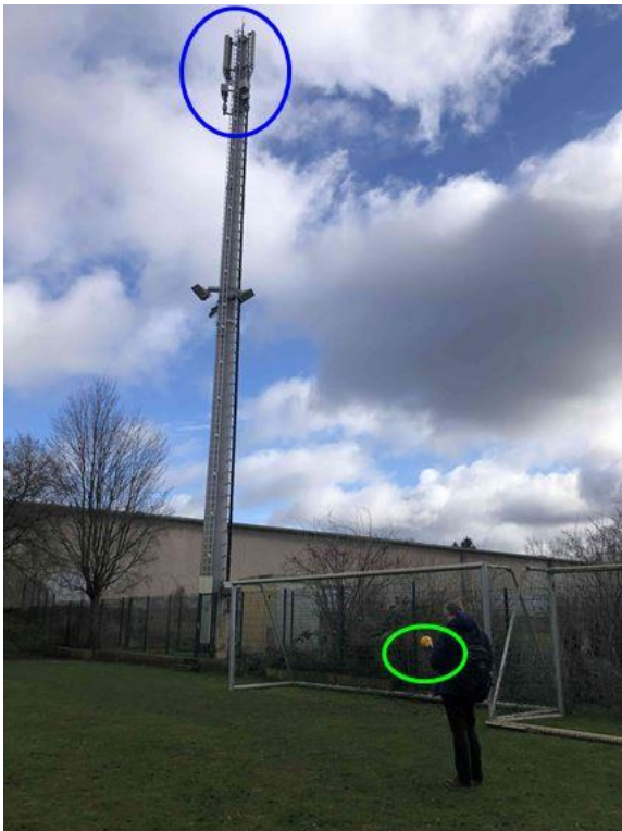
Bild A7: Messpunkt SZ3 mit Mobilfunkanlage
