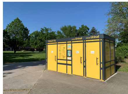
Abbildung 25: Autarke Trockentrenntoilette von EcoToiletten Quelle: SenMVKU
