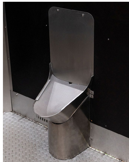
Abbildung 21: Unisex-Urinal Finizio, stehend und hockend nutzbar Quelle: SenMVKU
