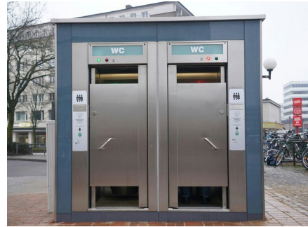
Abbildung 18: Sogenannte „Problemlöser-toilette“ in Köln mit Saloonfüren Quelle: https://www.ksta.de/koeln/muelheim/koeln-problemloeser-wc-auf-wiener-platz-in-koeln-muelheim-226840
