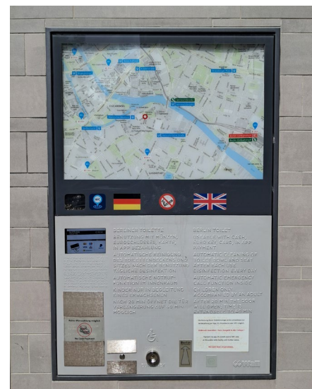
Abbildung 31: Frontpanel der Berliner Toiletten mit Brailleschrift, Informationen auf deutscher und englischer Sprache und Umgebungsplan mit Hinweisen auf die nächstgelegenen Toiletten
