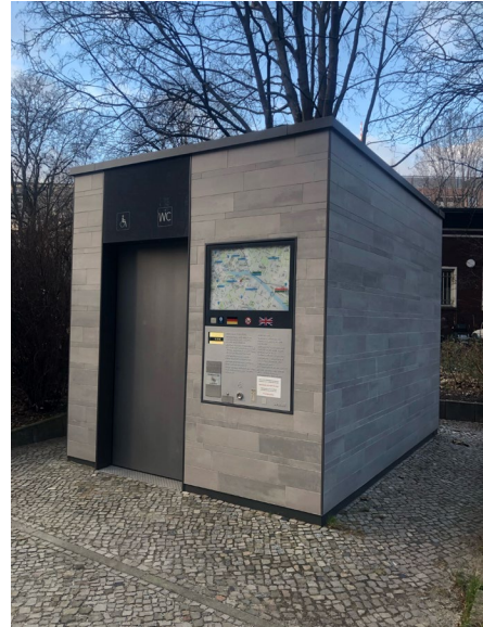
Abbildung 1: Berliner Toilette Quelle: SenMVKU
