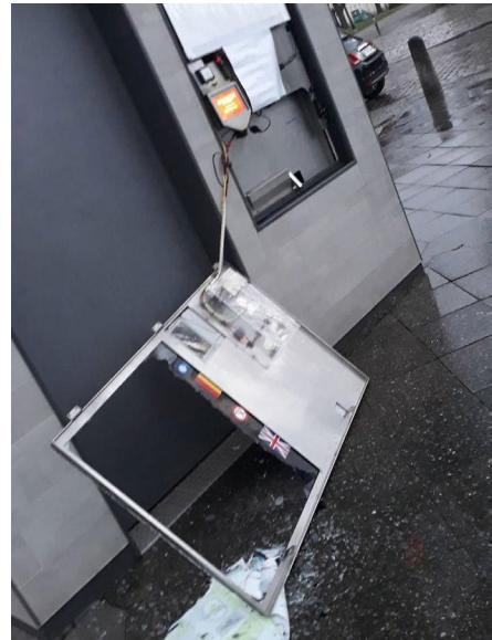
Abbildung 7: Schaden an einer Berliner Toilette durch Einbruchsversuch Quelle: SenMVKU
