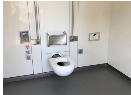
Abbildung 19: Innenraum der Berliner Toilette mit Notrufknöpfen sowie Spül- und Benutzungszeitverlängerungsknopf. Links ist der Toilettenpapierspender, rechts der Abfallbehälter zu sehen. An die Wand geklappt befinden sich die Haltestangen.
