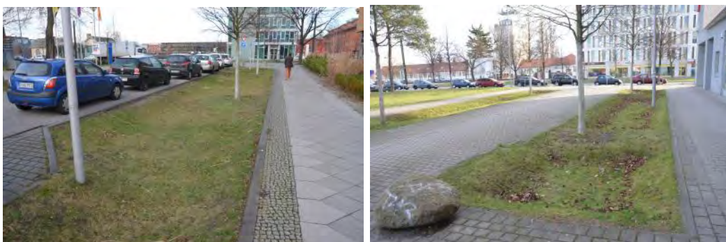
Mulden zur Entwässerung der Straßen und öffentlicher Wege in Berlin-Adlershof (hochC)
