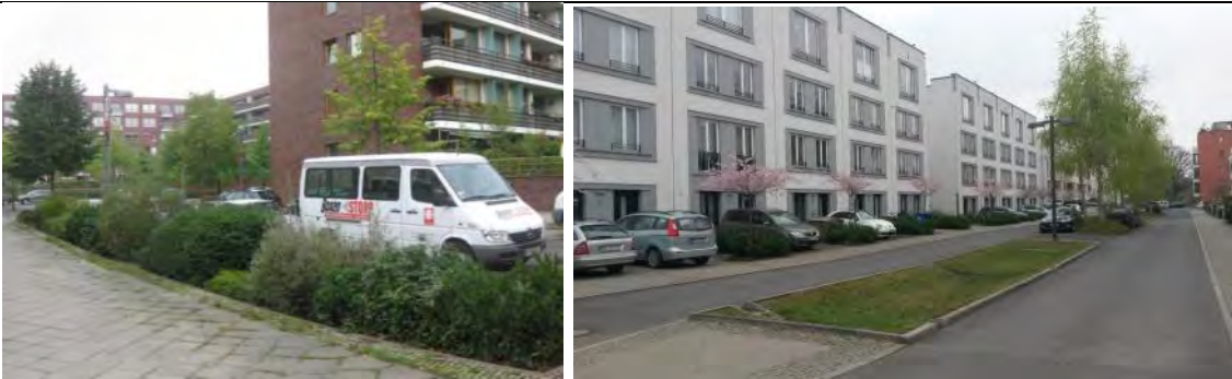
Mulden zur Entwässerung der Straßen und öffentlicher Wege in Berlin-Rummelsburg (Foto: IPS)
