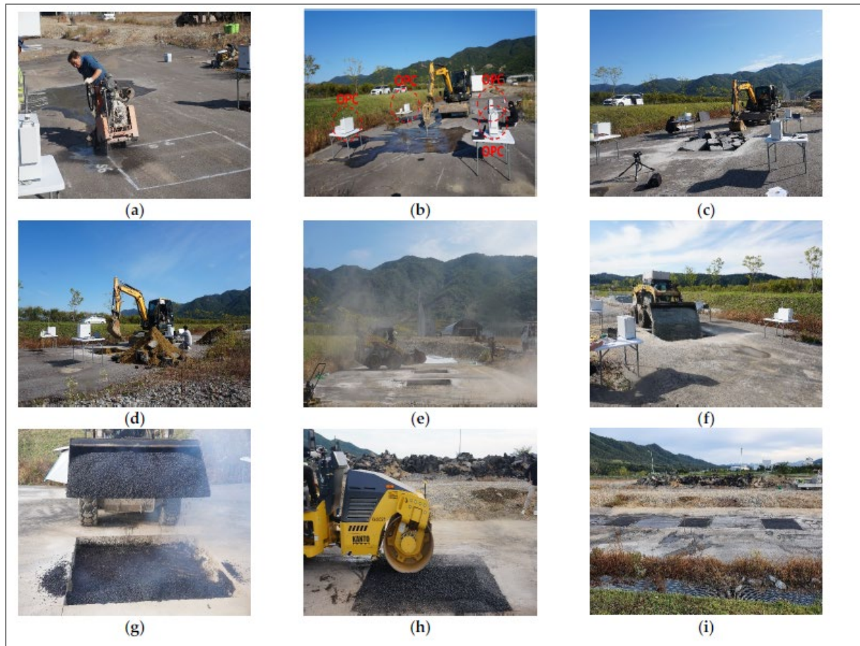
Bild 6.2: Von /Han et al. 2023/ hinsichtlich Feinstaub-Emissionen untersuchte Arbeitsschritte einer Straßenbaustelle: (a) Schneiden, (b) Brechen, (c) Entfernen der Bruchstücke, (d) Aushub, (e) Kehren, (f) Restaurierung, (g) Asphaltverlegung, (h) Verdichtung und (i) fertiggestellte Asphaltdecke; Quelle: /Han et al. 2023/
