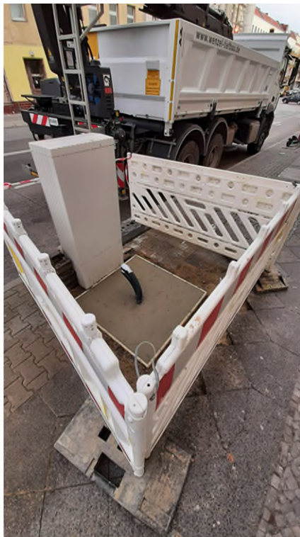
Abbildung 18: vlnr.: Standortmarkierung des neuen Containers QS3; vorbereitetes Fundament mit Kabelschutzrohren und bereits installiertem Stromanschlusskasten; QS3 am finalen Standort in der Silbersteinstraße. (Quelle: Berliner Luftgütemessnetz)
