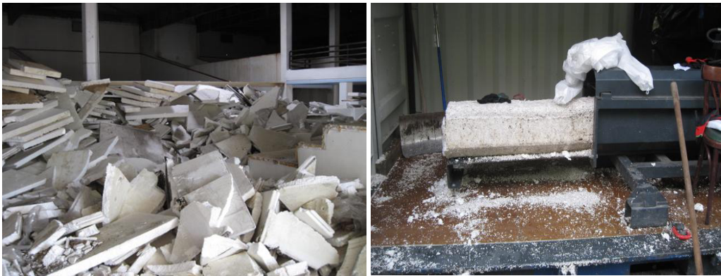
Abbildung 5: Zwischenlager EPS auf der Baustelle (links) | kompaktiertes EPS (recyclingfähig) (rechts)
