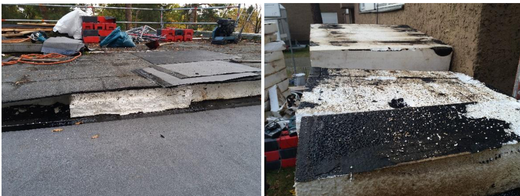
Abbildung 4: EPS-Platten vor dem Ausbau (links) und nach dem Ausbau (rechts) mit mehr oder weniger Bitumenresten durch die Heißverklebung auf der Unterseite
