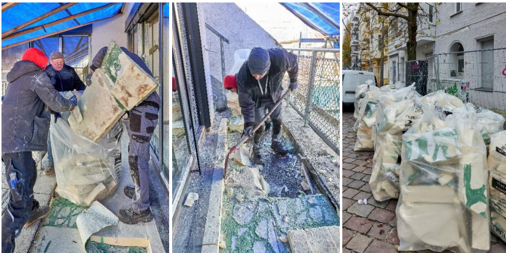
Abbildung 8: Rückbau von verklebten PU-Dämmplatten (Quelle: IVPU)
