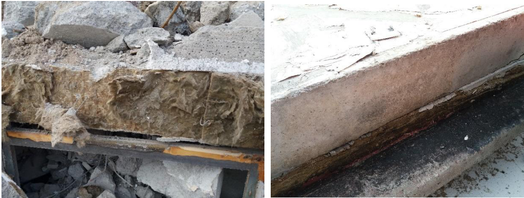
Abbildung 6: Mineralwolle freigelegt aus Beton-Sandwichelement (links); Sandwichelement vor dem Rückbau (rechts)
