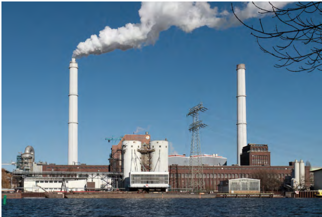
Abb. 19: Kraftwerk Klingenberg in Berlin-Rummelsburg.
