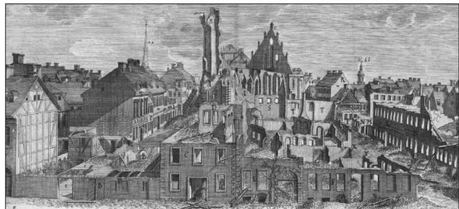
Ruinen der mittelalterlichen Petrikirche und der Lateinschule nach dem Brand von 1730
