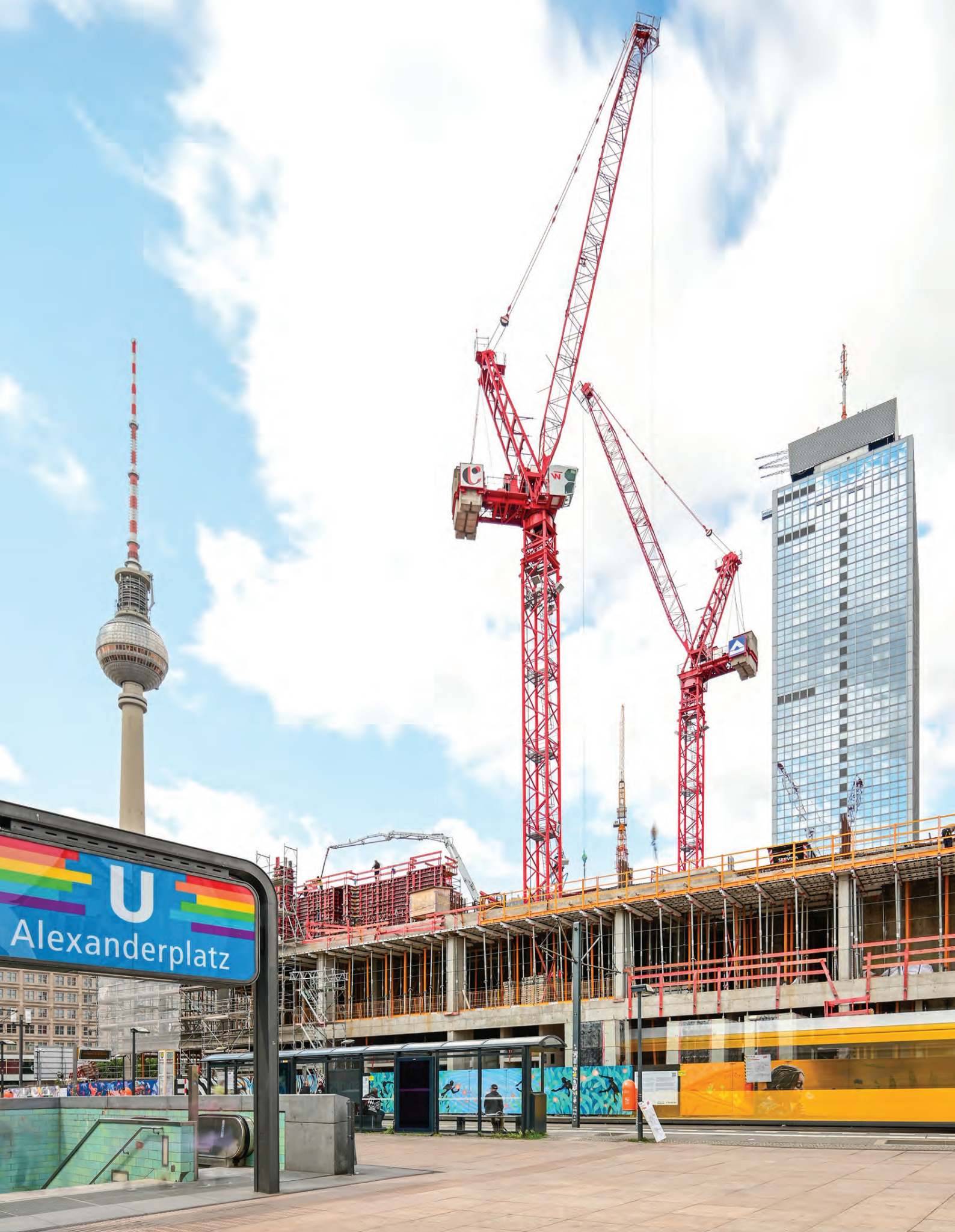
Abbildung 50: Baustelle der Hochhaus-Neubauten am Alexanderplatz © Sebastian Steinberg
