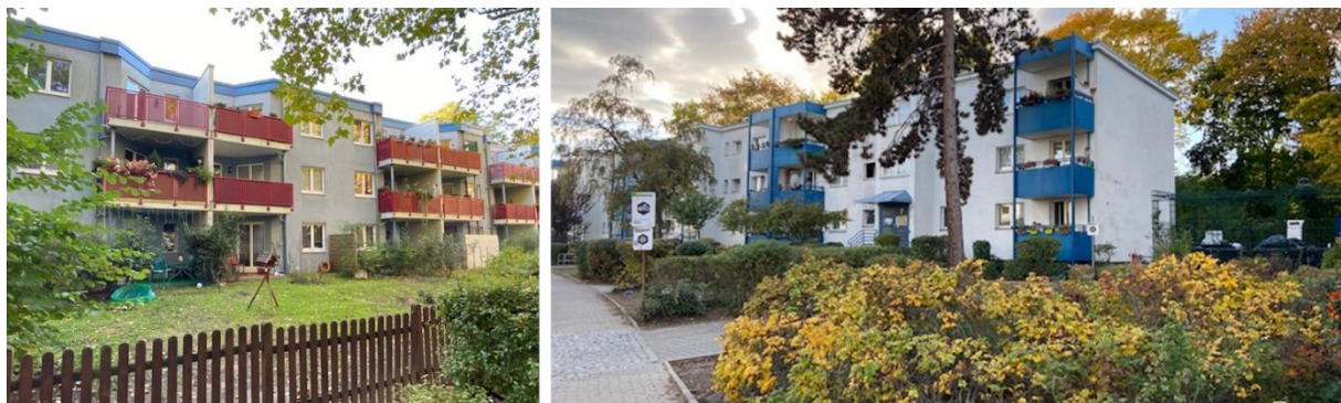
Abbildung 1.3: Privateigentum und Gebäude im Nordwesten
