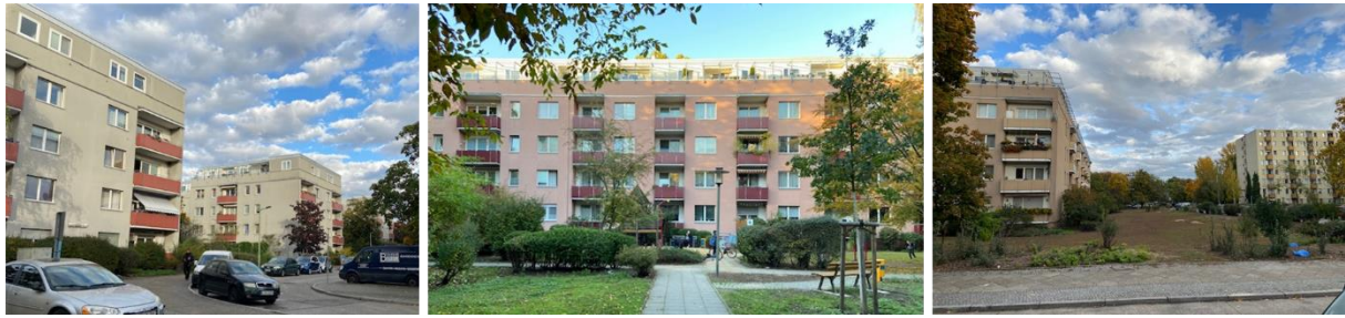
Abbildung 1.1: 5 und 8-geschossige Wohnungsbestände der Gewobag
