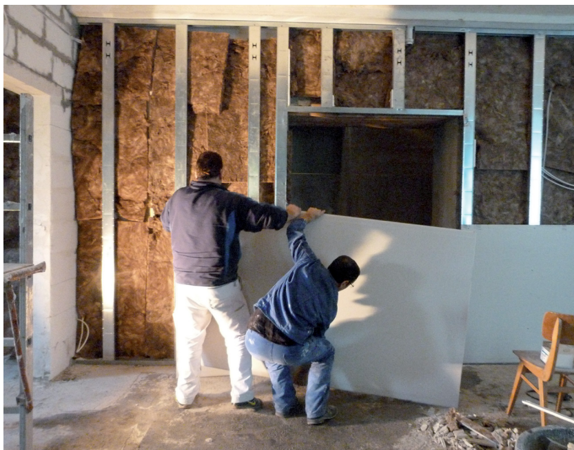
Baerwaldbad während des Umbaus © Zukunftsbau GmbH
