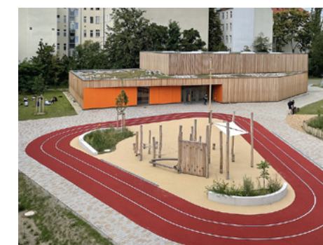
3 Neubau einer Sporthalle für die Johannes-Schule Berlin: Die Einfeldsporthalle wurde wie alle Gebäude des Campus in Holzbauweise errichtet und erhielt eine extensive Dachbegrünung. © C. Mildenberger, Johannes-Schule Berlin
