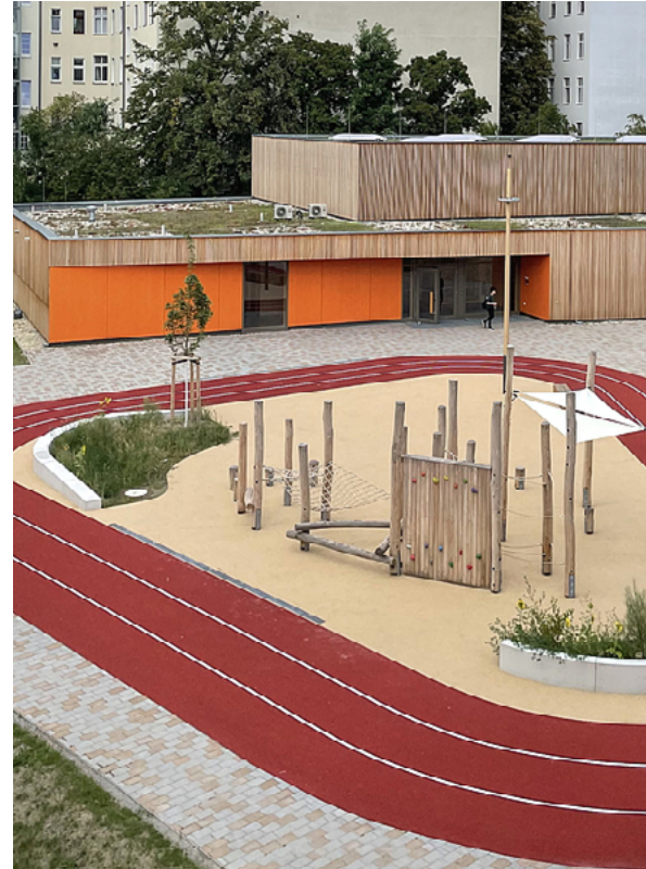
Neubau von Sporthalle, Laufbahn und Bewegungsparcours für die Johannes-Schule © C. Mildenerger, Johannes-Schule
