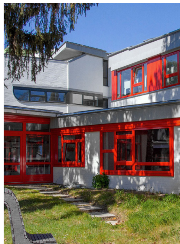
Atrium nach der energetischen Sanierung © Bianka Gericke
