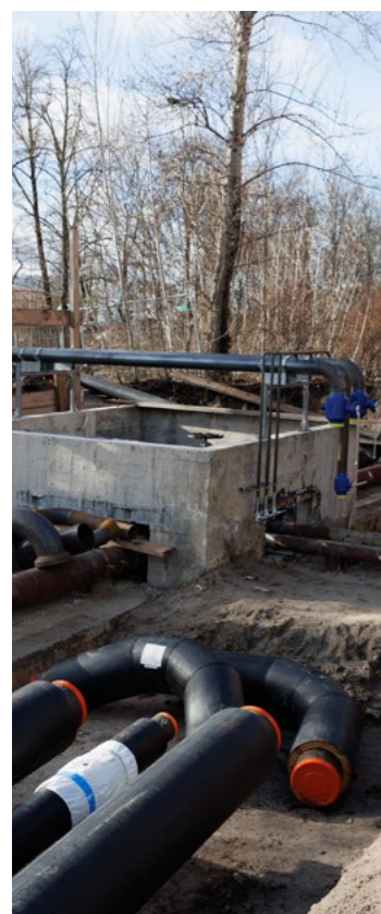
Laufende Arbeiten am Reichweindamm
