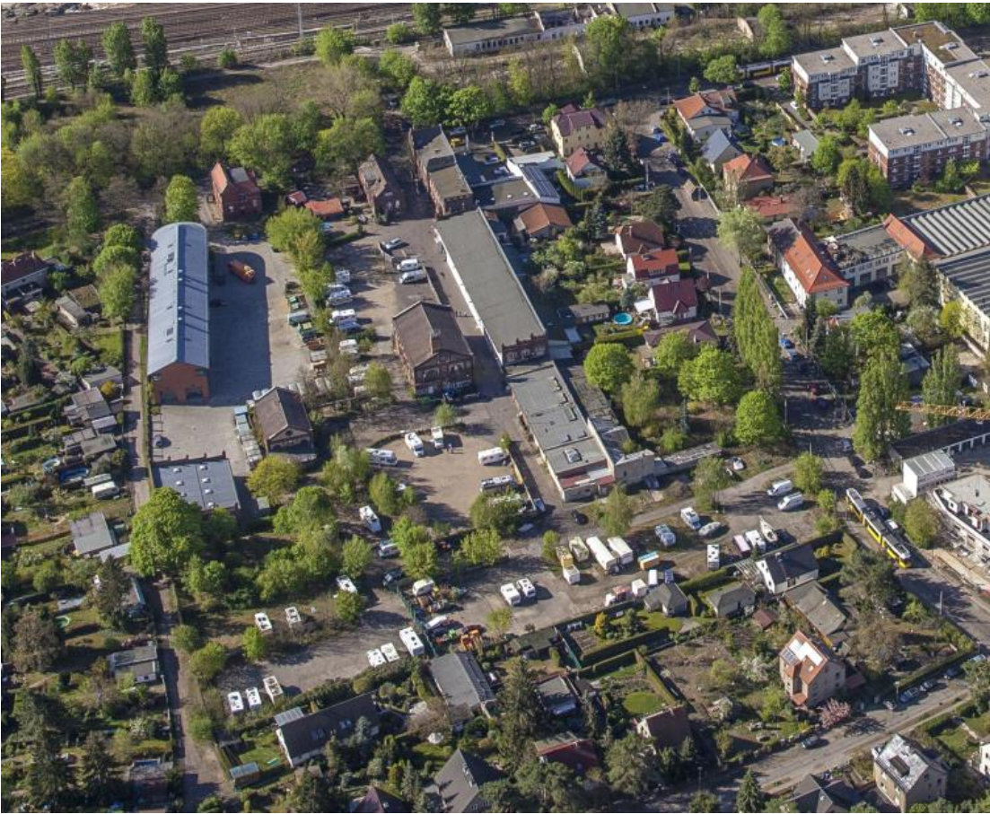
© Laubner 2019 - Schrägluftbild Gaswerk aus Norden
