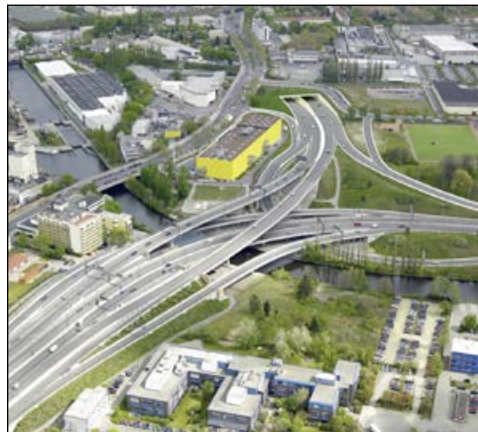
Autobahndreieck Neukölln (im Bau)
