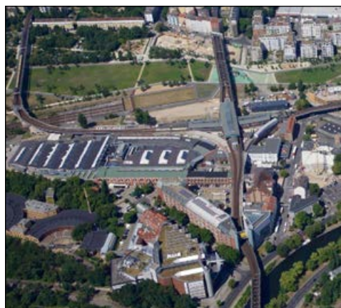
Bahntrassen am Gleisdreieck
