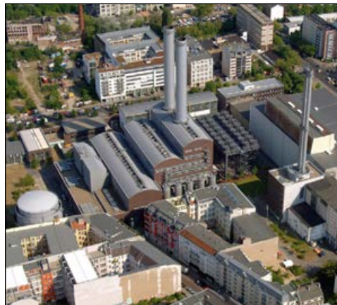
Heizkraftwerk Mitte im Vorranggebiet Luftreinhaltung
