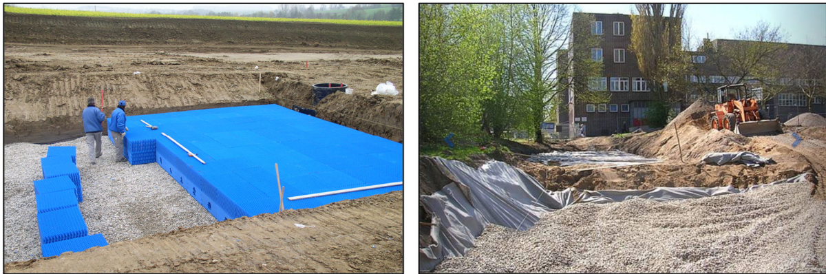
Abbildung 27: Füllkörper-Rigole (l) und Kiesrigole (r)
