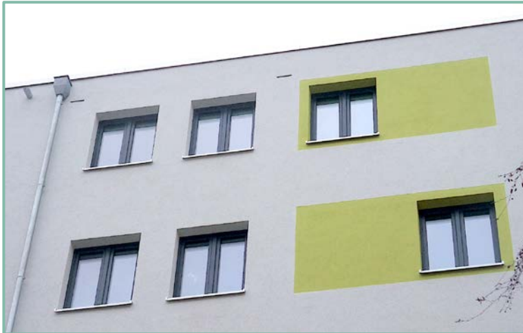
Abb. 57: Integration von Fledermaus- verstecken (Fledermauseinlaufblende 1FE) in einen Neubau. Eckertstraße 3A, 4A, 5A, Petersburger Straße 72D, 72E in Berlin-Friedrichshain, 2019.
