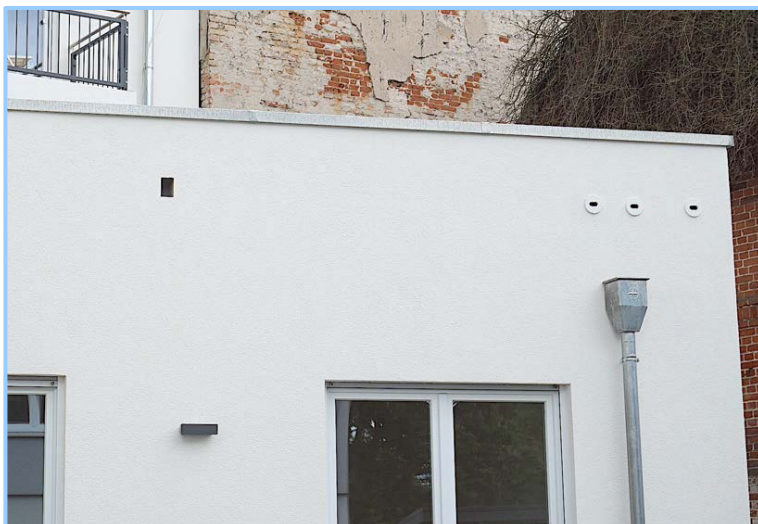
Abb. 56: Integration von einem Mauersegler- kasten 17A, dreifach und einer Halbhöhle 1HE für Hausrotschwänze in einen Neubau. Tino-Schwierzina- Str. 5 in Berlin-Heinersdorf, 2021.
