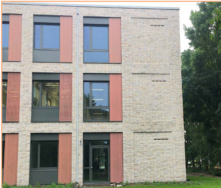
Abb. 55: Integration von Fledermaus- verstecken (Fledermauseinlaufblende 1FE) in das Gerty-Cory-Haus, Deutsches Institut für Ernährungs- forschung in Potsdam-Rehbrücke (Foto: DIfE 2021).
