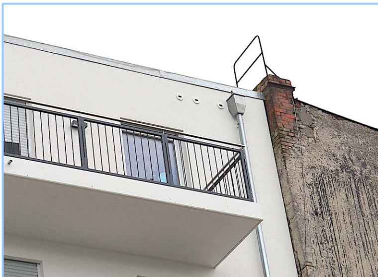
Abb. 58: Integration von einem Mauerseglerkasten 17A, dreifach in einen Neubau. Tino-Schwierzina- Str. 5 in Berlin-Heinersdorf, 2021.
