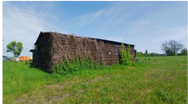
Abb. 26: Das sich auf dem UG befindenden Gebäude. Blickrichtung von Süden aus
