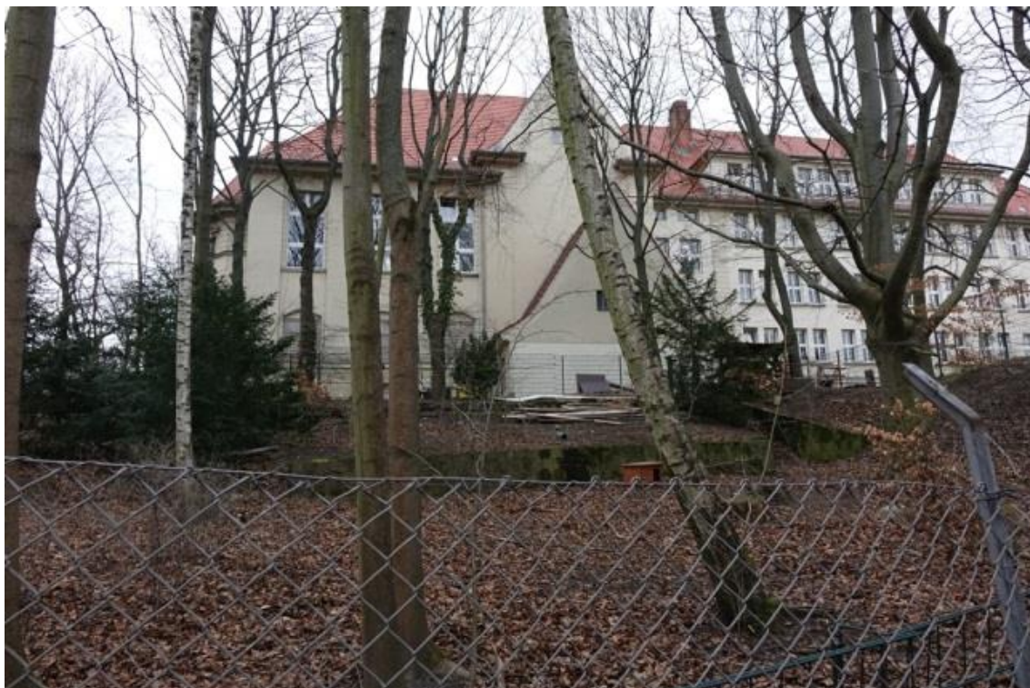
Abb. A-4: Zaun am Grundstück der Alfred-Nobel-Schule am Ostrand der trocken liegenden Senke des Großen Eckerpfuhls auf dem ehem. RIAS-Gelände (Foto: Hofmann am 20.03.2023).
