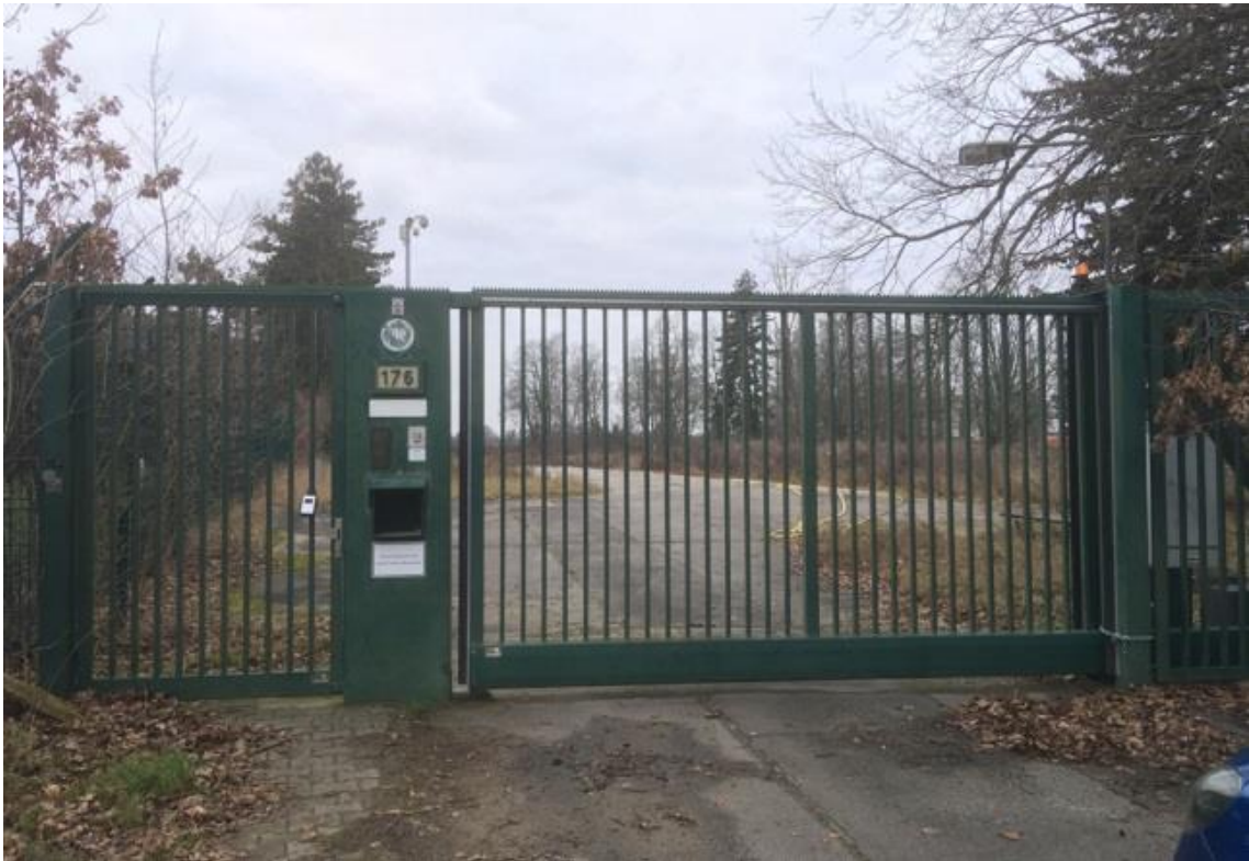
Abb. A-1: Rolltor an der einzigen Zufahrt zum ehem. RIAS-Gelände (Foto: Hofmann am 23.01.2023).
