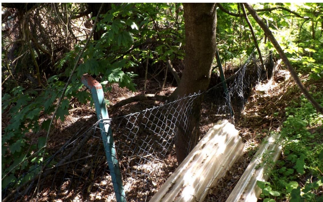
Abb. A-6: Zaunreste im Bereich der alten Baumweide (UBB 05/2023).
