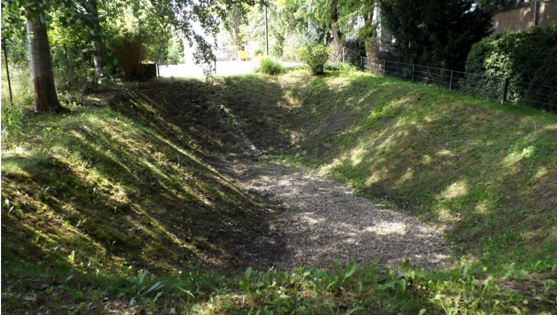
Abb. A-7: Rückhaltebecken unmittelbar neben (westlich) dem Brandpfuhl (UBB 05/2023).
