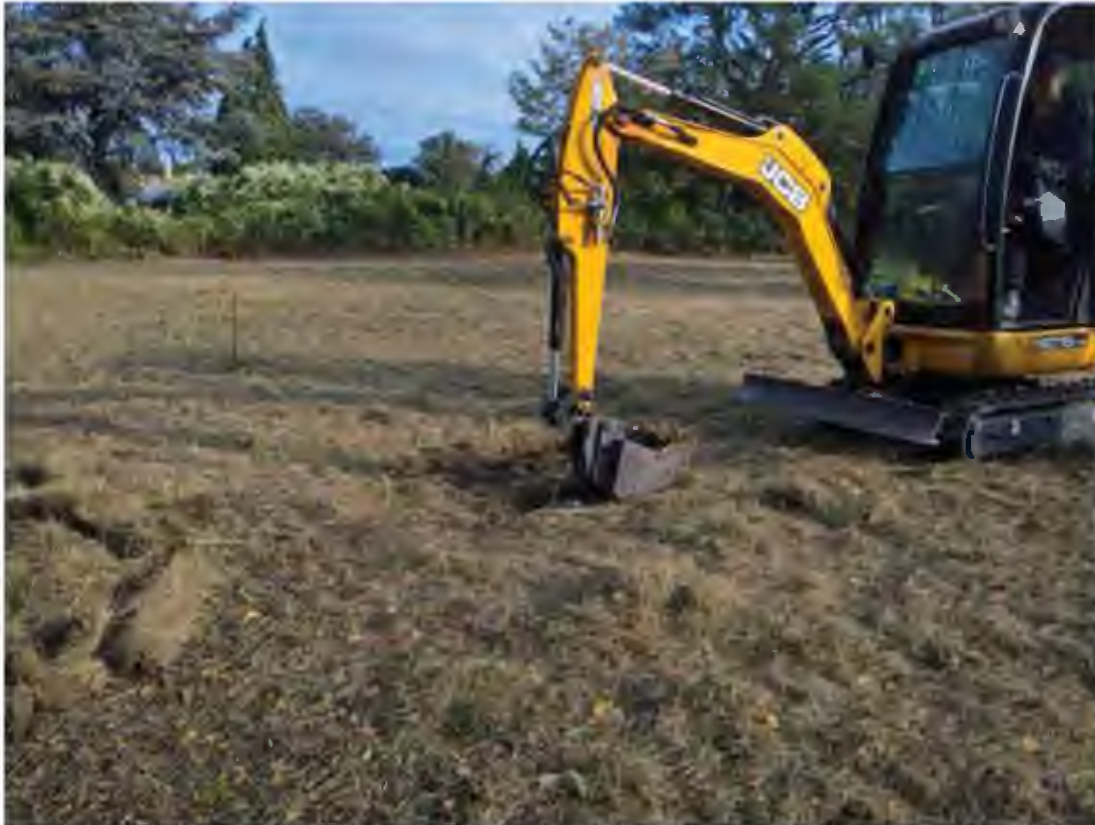
Abbildung 13: Herstellung Baggerschurf
