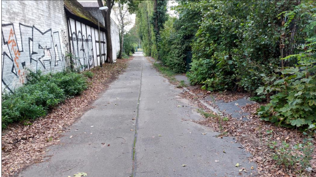
Abbildung 61: vorhandener Zufahrtsweg (Blickrichtung West, Foto FGS)
