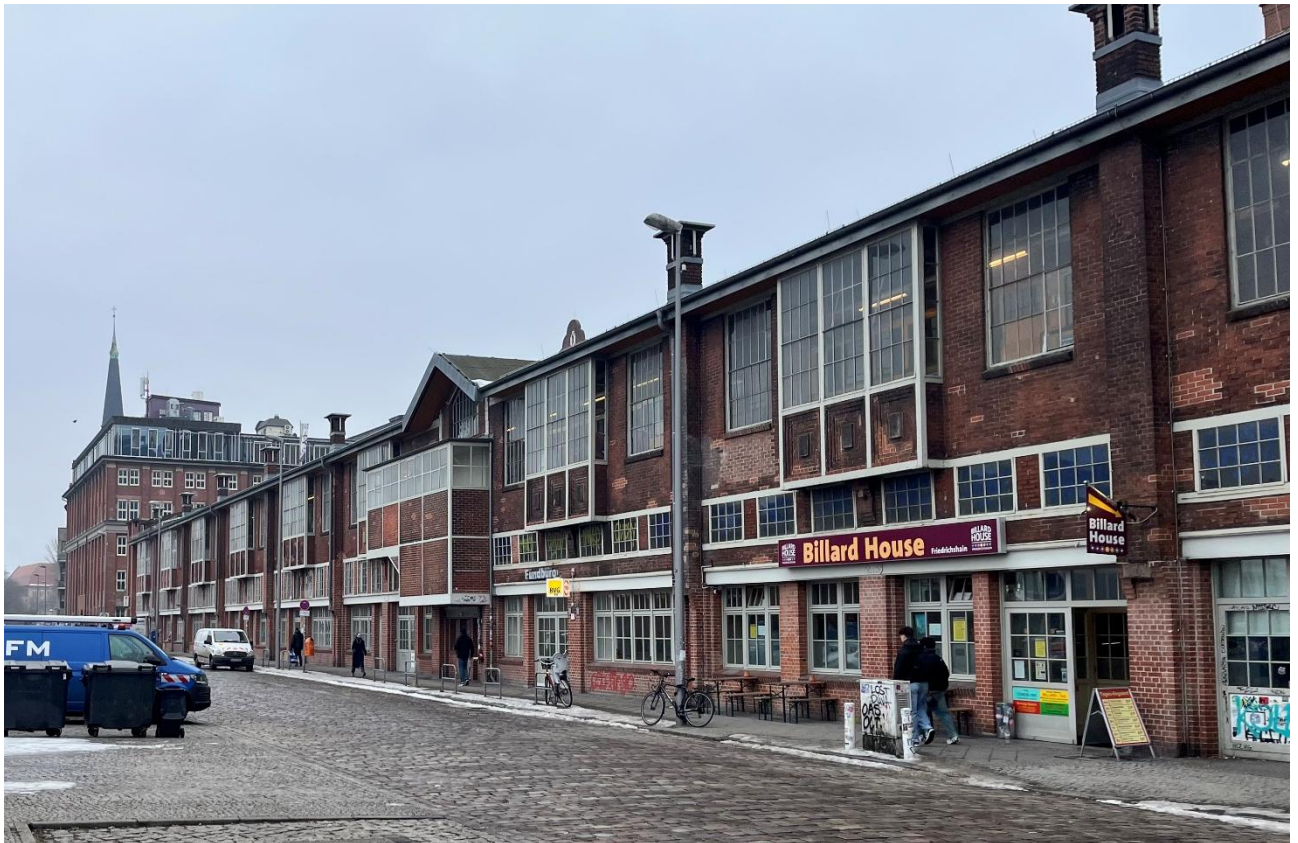
Bild 3-4 Ansicht BVG-Betriebsgebäude Rudolfstraße 1-8, Blick Richtung Südosten
