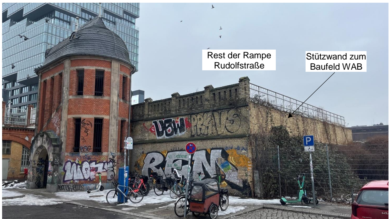
Bild 3-3 Rest der Rampe Rudolfstraße und Stützwand zum Baufeld, Ansicht von Südosten
