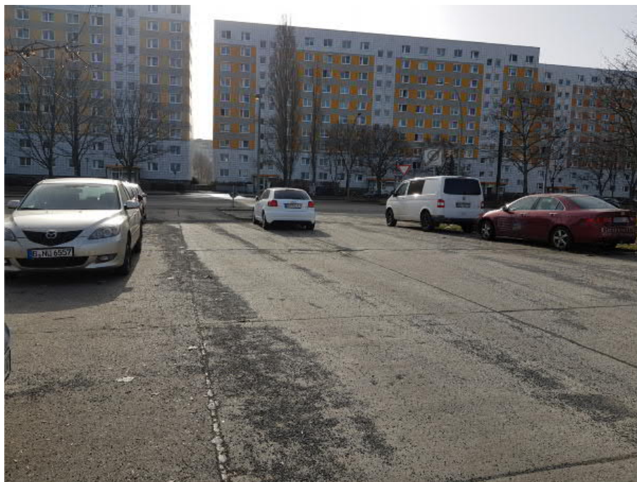
Ausfahrt Parkplatz Hohenschönhauser Straße
