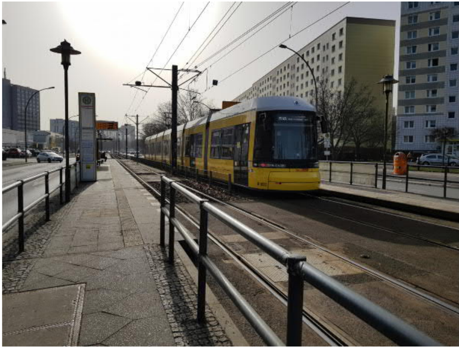
Straßenbahnhaltestelle Hohenschönhauser Str. in Blickrichtung Süden
