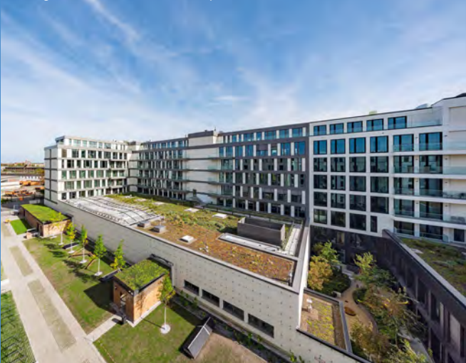
Wohngebäude an der Ella-Barowsky-Straße
