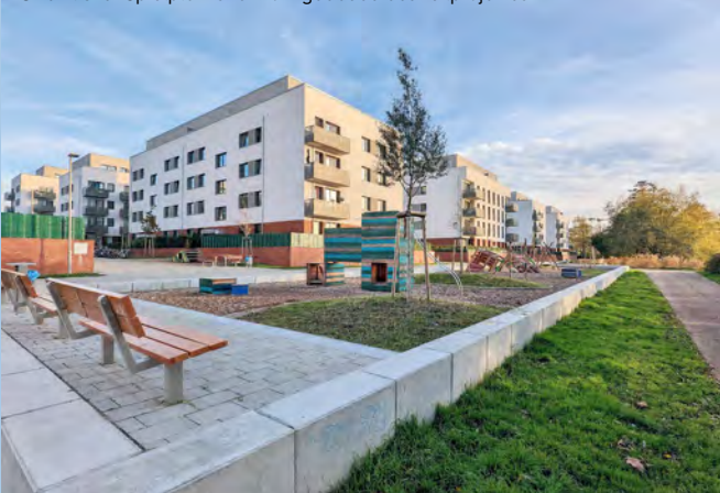
Öffentlicher Spielplatz und Wohngebäude des Teilprojektes WATERKANT
