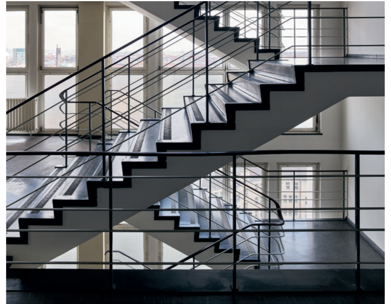
S. 64. Treppenhaus im südlichen Teil des Bürohochhauses, 17. OG. Blick nach Nordosten über die Stadt. Eine Farbbefunderhebung hat ergeben, dass das Treppenhaus bauzeitlich auch blau gestrichen war.
