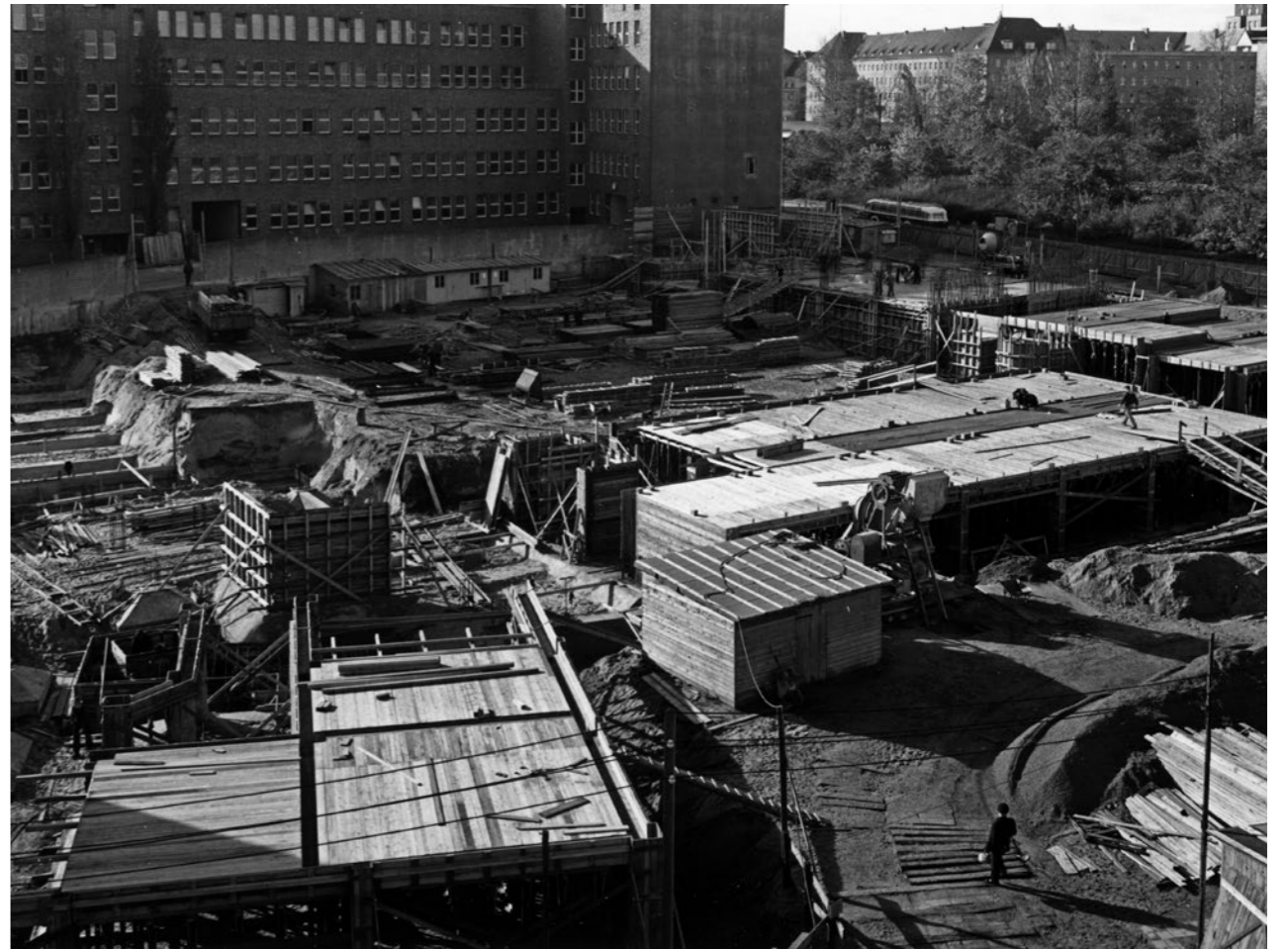
S. 16-17. August 1955. Blick von der Pommerschen Straße auf den Rohbau. Gut zu erkennen im Vordergrund der markante Erker des großen Sitzungssaals, der sich über zwei Etagen erstreckt.
