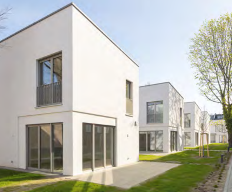
Gounodstrasse © GESOBAU AG/Thomas Bruns
