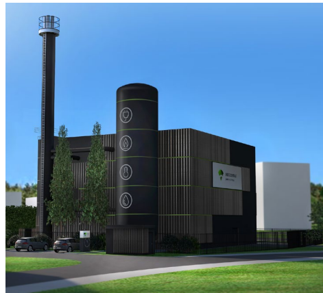
Abbildung 8: Lokale Energiezentrale für Strom und Wärmeerzeugung (BHKW)
