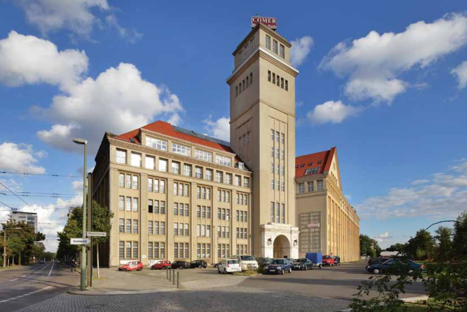
Große städtebauliche Geste am Ende der Wilhelminenhofstraße: Dreiflügelige Geschossfabrik der NAG mit dem markanten Wasser- turm von Peter Behrens
