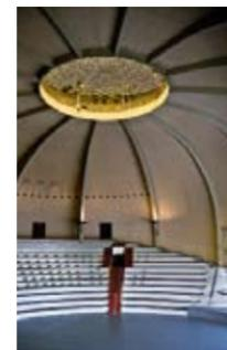
**Der Kuppelsaal** ist Bestandteil des Hauses des Deutschen Sports. Er hat eine sichtbare Eisenbeton-Rippendecke. Der Grundriss ist elliptisch und misst 37 x 43 m mit einer lichten Höhe von 17 m. Als Lichtquelle dient ein Tambour von 14 m Durchmesser, mit einer Höhe von 5,50 m, bestückt mit 3.400 Prismengläsern. Die Sitzstufen sind wie in einem Amphitheater angeordnet und bieten 1.100 Zuschauern Platz. Hier fanden während der Olympischen Spiele 1936 Fechtwettkämpfe statt.
