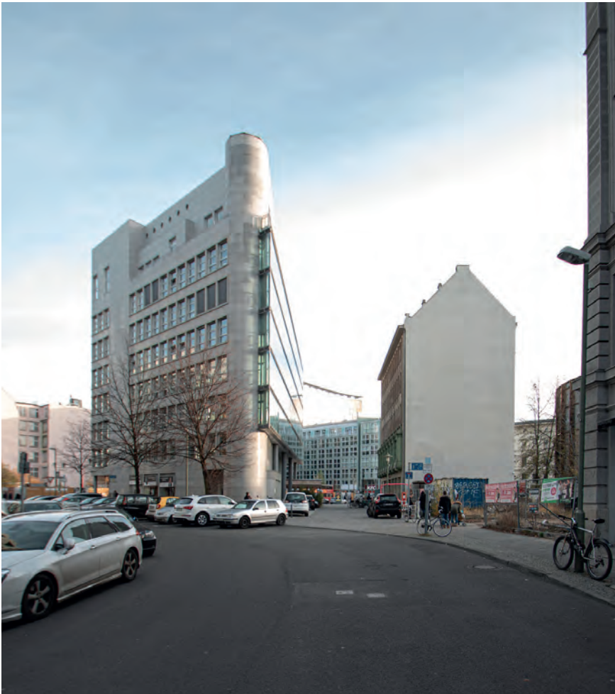
Abb. 9: Bestandsgebäude „Haus Triangel“ (Quelle: SenStadt)
