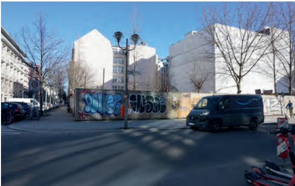
Foto 22: Kreuzung Friedrichstraße/Schützenstraße, Blickrichtung Osten auf Brandwand Zimmerstraße 79-80
