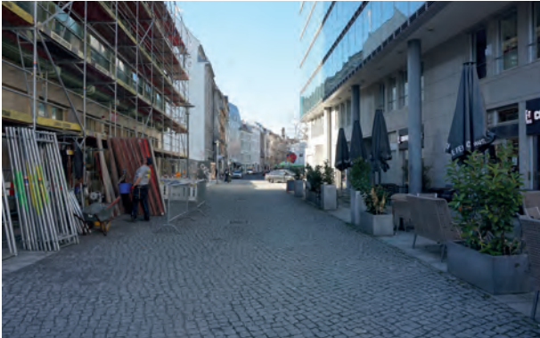
Foto 29: Mauerstraße Straßenraum, Blickrichtung Nordwesten zum Bethlehemkirchplatz
