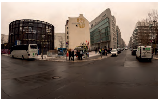
Foto 26: Kreuzung Friedrichstraße/Zimmerstraße, Blickrichtung Nordwesten auf das Museum „Die Mauer/The Wall“, Mauerstraße 93 und Haus „Triangel“
