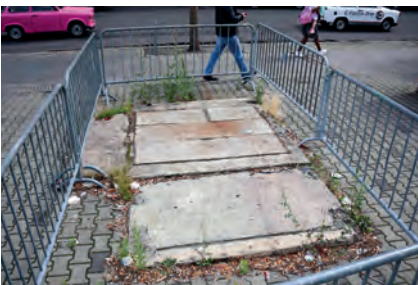
Abb. 26: Fundamentrest am südlichen Rand des Stadtplatzes. Wahrscheinlich teilweise abgetragener Kabelschacht innerhalb des Hochbeetes im ehemaligen Grenzstreckenabschnitt (Quelle: Stiftung Berliner Mauer, 2025)
