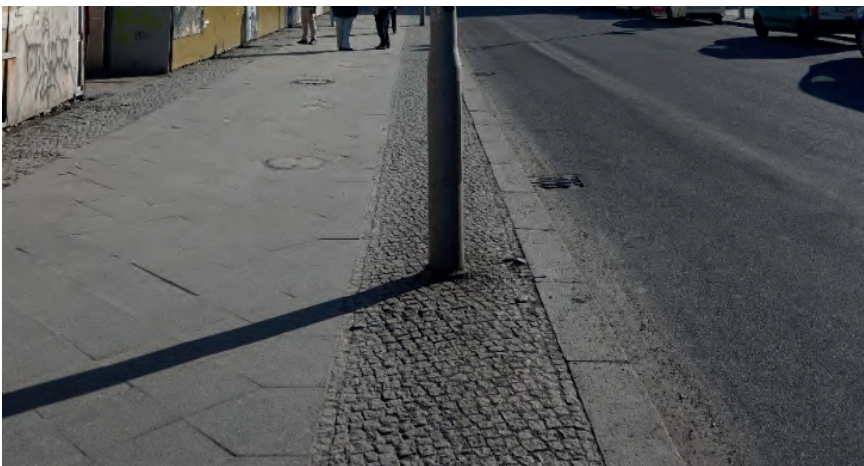
Abb. 61: Friedrichstraße Bodenbeläge Gehweg und Straße (Quelle: ISR, 2026)
