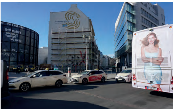
Foto 3: Gebäude Mauerstraße 93 und Haus „Triangel“, Blickrichtung Mauerstraße
