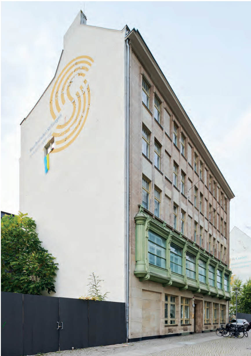
Abb. 8: Bestandsgebäude Mauerstraße 93 mit Observationsfenster (Quelle: Andrew Alberts, 2023)
