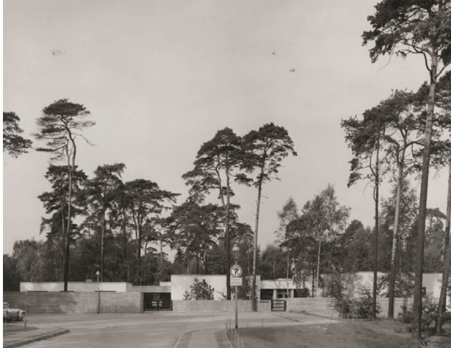
Abb. 5: Blick auf Brücke-Museum vom Bussardsteig früher
