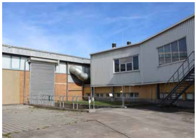
Abb. 23: Rolltor mit Rampe als barrierefreier Zugang, rechts Nordfassade des Technikgebäudes
