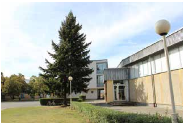
Blick nach Nordwesten auf Regieturm und Pressezugang
