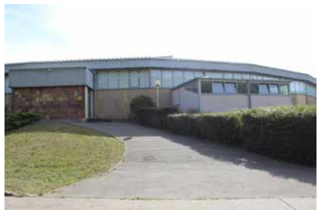
Blick von Friedhofsmauer auf Garagenanbau für Eismaschinen (rechts), Zufahrt zur Hallenumfahrung
