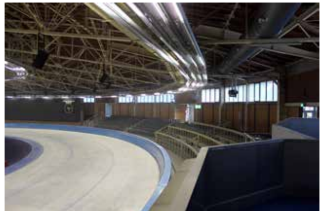
Rechts Presstribüne, links Anzeigetafel, vorne südlicher Balkon des Regietrakts
