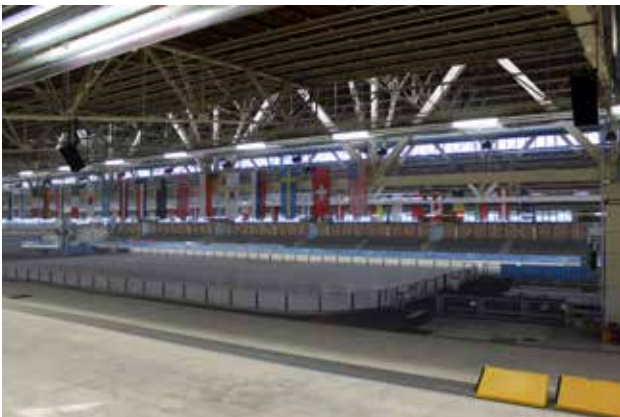
Blick von Regietrakt auf die innere Eisfläche
