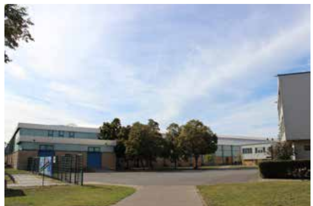
Blick von südlicher Hallenumfahrung auf Eingangsp- platz, links Zaunanlage zur Konrad-Wolf-Straße
