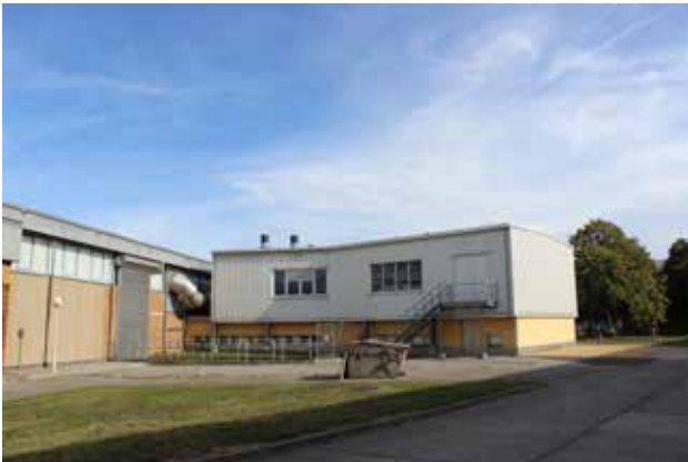
Nordfassade des Technikgebäudes
