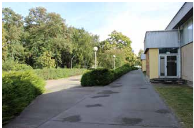
Abb. 8: Blick Richtung Konrad-Wolf-Straße, rechts höhergelegene Rettungs-Anlieferumfahrung mit Zuschauerzugängen
