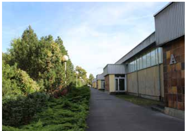
Abb. 21: Ostfassade mit Zuschauerzugängen
