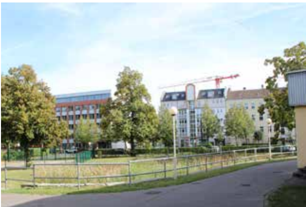
Blick auf Regenversickerungsbecken, rechts Eisschnelllaufhalle, Hintergrund Konrad-Wolf-Str.
