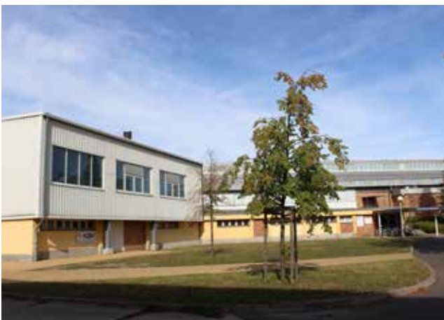
Abb. 22: Links zweigeschossiges Technikgebäude, rechts Eingangsbäude
