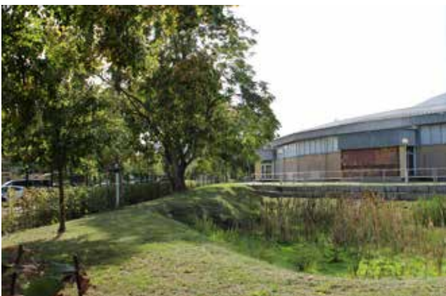
Abb. 9: Im Vordergrund das Regenwasserversickerungsbecken, links die Parkzone an der Konrad-Wolf-Straße
