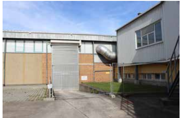
Rolltor neben Technikgebäude als barrierefreier Zugang zur Eisschnelllaufhalle
