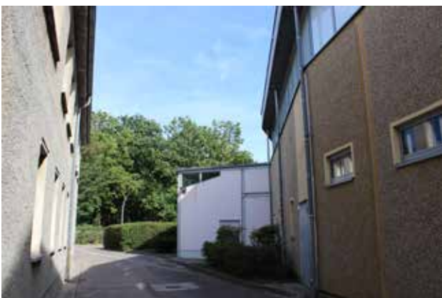
Rechts Eisschnelllaufhalle mit Garagenanbau für Eismaschinen
