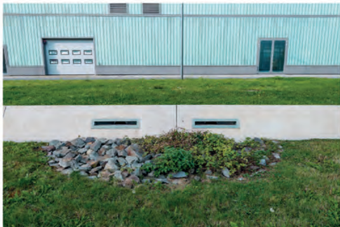
Atos-Gebäude Adlershof. Quelle: A. Süß
