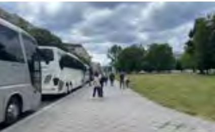
Spandauer Straße – bereits sanierter Gehweg mit berlintypischer Gliederung
