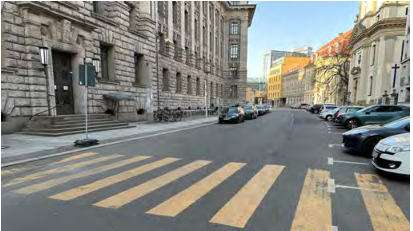
Klosterstraße am Alten Stadthaus – Bestandssituation
