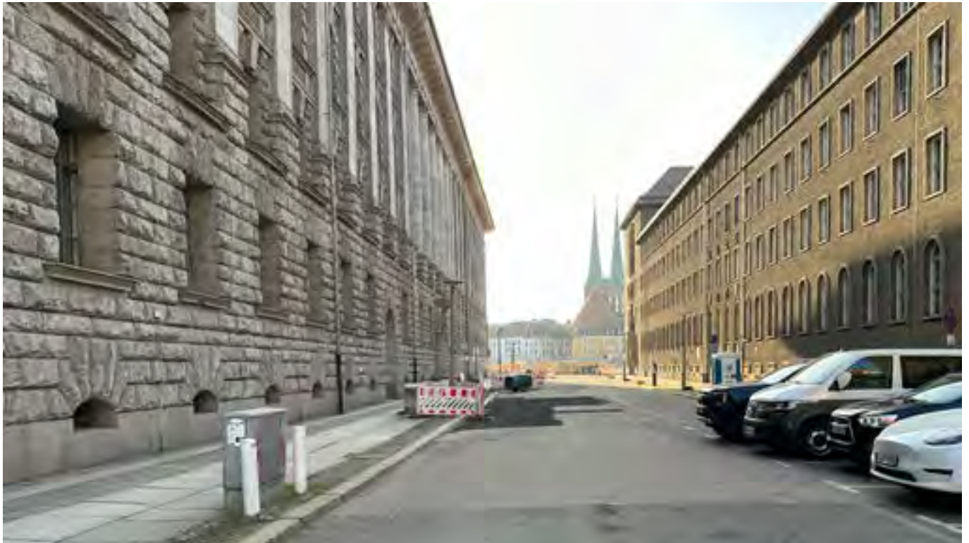
Westlicher Abschnitt Parochialstraße am Alten und Neuen Stadthaus – Bestandssituation
