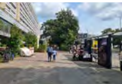
Karl-Liebknecht-Straße – bauzeitliche Gestaltung mit in Reihe verlegten Gehwegplatten
