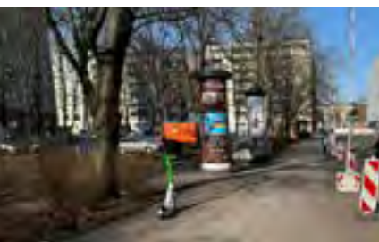
Fischerinsel – Haupteinfahrtsstraße mit Beton-Gehwegplatten in Reihe verlegt
