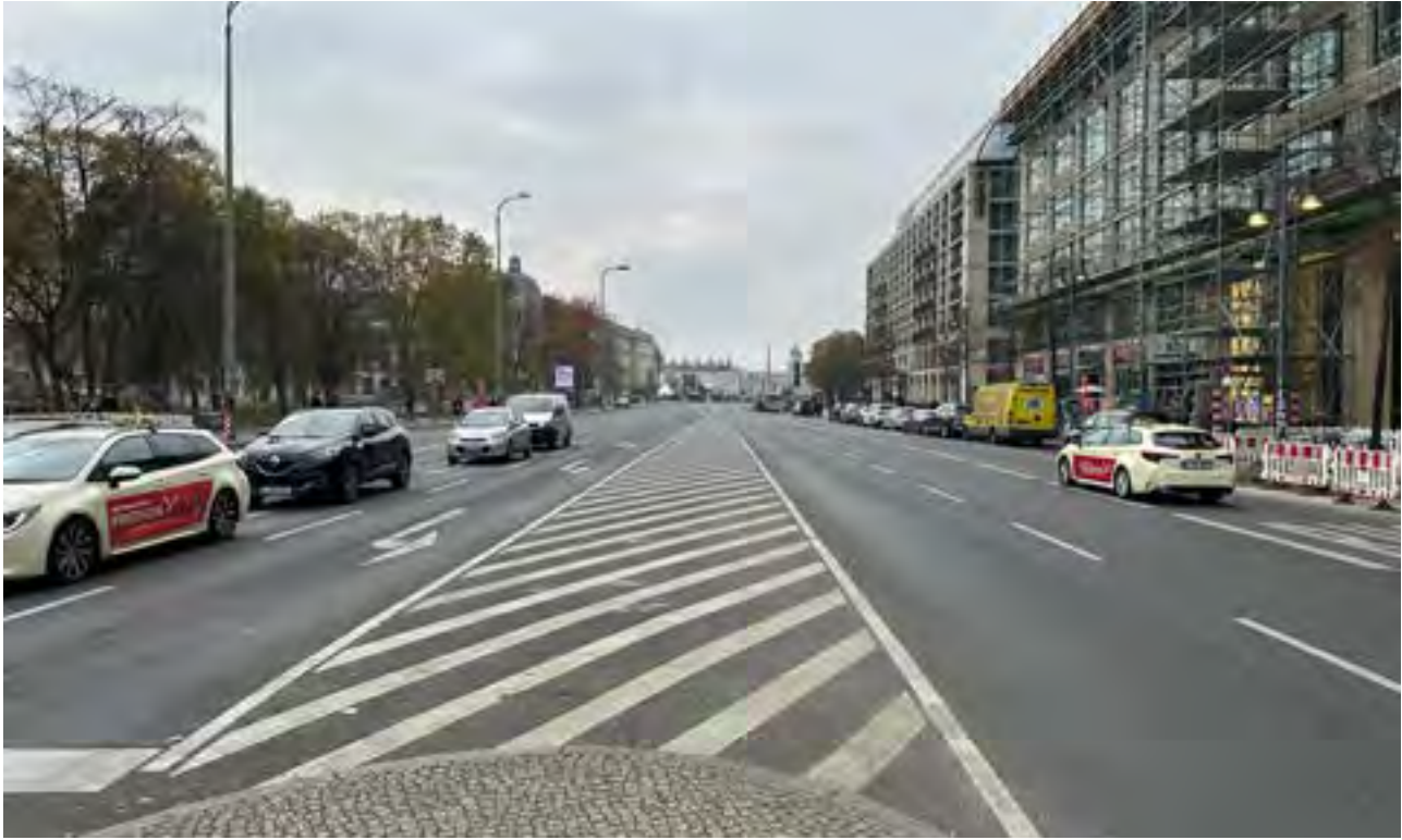
Karl-Liebknecht-Straße 5, Blickrichtung Schloßplatz – Bestandssituation
