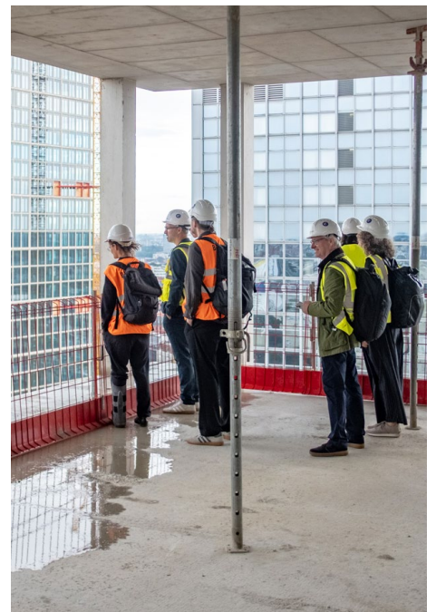
Begehung der Baustelle von Baufeld D3 am Alexanderplatz
