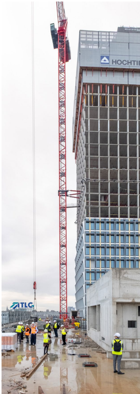
Begehung der Baustelle von Baufeld D3 am Alexanderplatz
