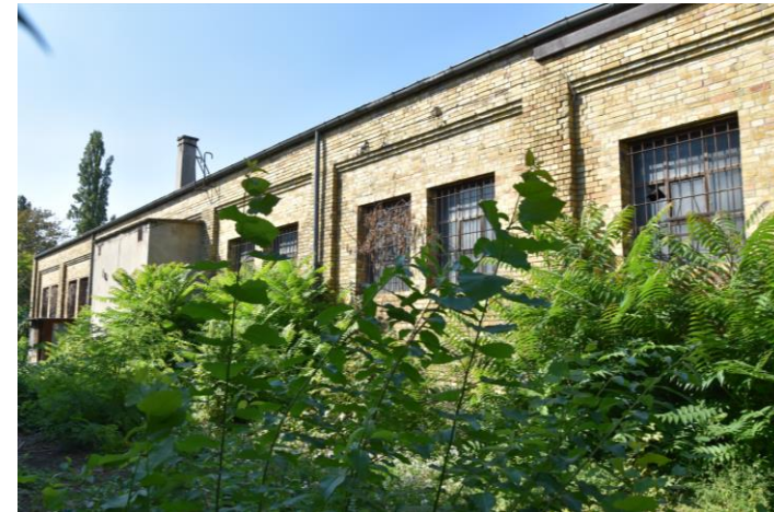
Neue Reithalle, Einsehbarkeit von Osten
