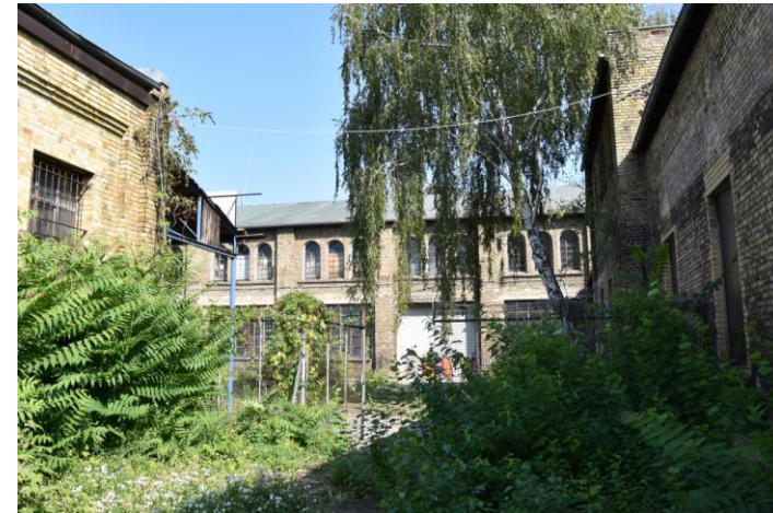
partielle Ansicht auf das Dach der Alten Reithalle von entfernten Positionen aus (neben der Neuen Reithalle)
