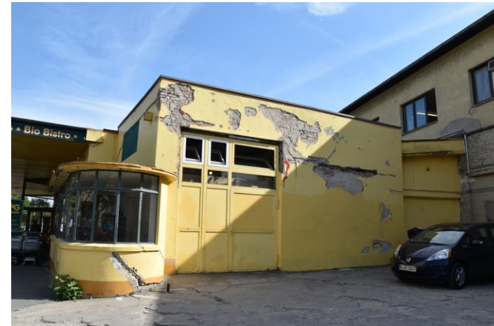
Tankstellendach, Waschstraße und Zwischenbau (Geb. 35/53)
